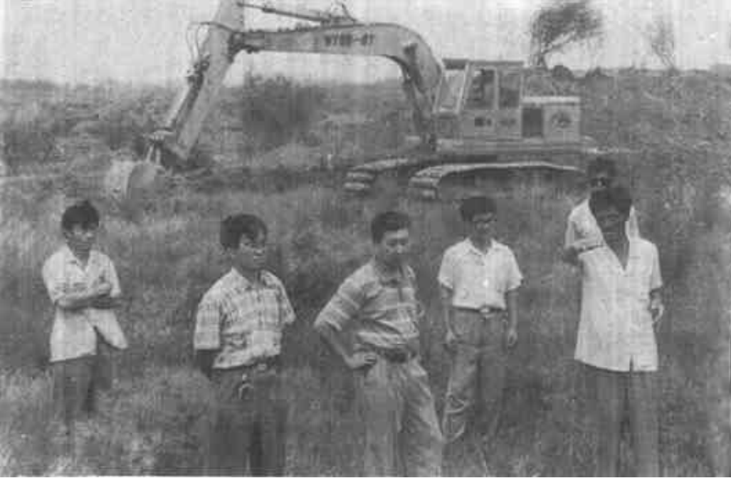
▲市科委包村工作组，自进驻垦利县胜利镇张盖村以来，为该村的经济出谋划策，无偿投资万元帮助该村开发蓄水量30万立方米的村西水库。目前，工程进展顺利，预计年底可全部完工。图为包村干部与村干部一同察看施工现场。（本报记者 徐兆鹏 摄）
